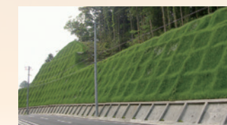
のり面事業 (GTフレーム工法®)
